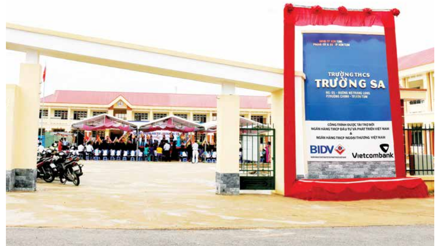
Toàn cảnh công trình Trường trung học cơ sở Trường Sa do Vietcombank và BIDV đồng tài trợ kinh phí xây dựng
