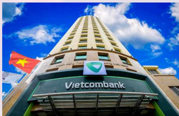
Tòa nhà TSC Vietcombank tại 198 Trần Quang Khải, Hoàn Kiếm, Hà Nội.
