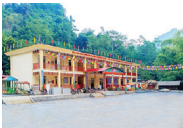
Công trình Nhà lớp học Trường Mầm non Bán Thi do Vietcombank tài trợ
