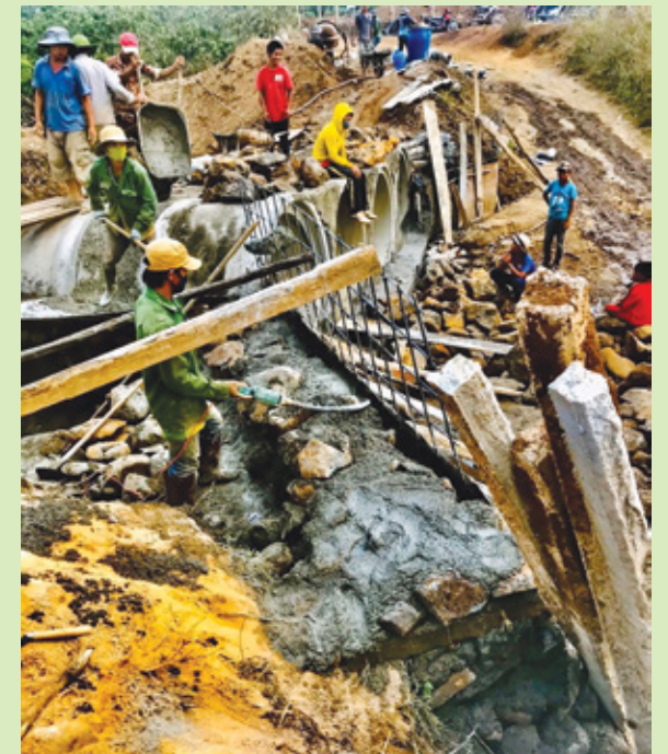
Bà con 3 xã Nam Yang, Hà Bấu, Đăk Rông chung tay sửa chữa cầu Suối Cát
